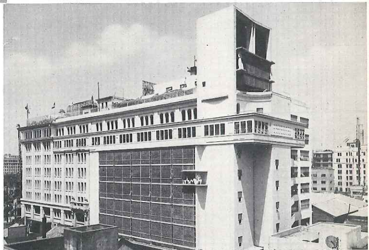
▶ 日生高島屋増築工事 (東京都中央区日本橋) 設計 村野・森事務所殿 施工 大林組殿 工期 昭27.2~昭27.4
