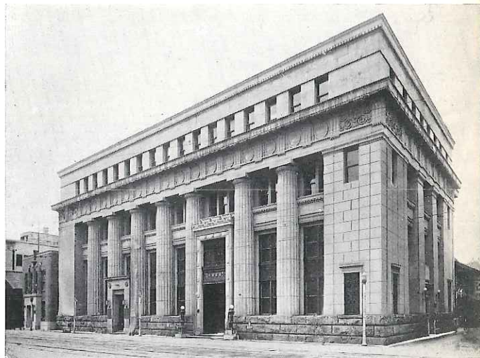
▲ 富士銀行福岡支店 (福岡市天神町) 設計 渡辺仁建築事務所殿 施工 清水建設殿 工期 昭2~3
