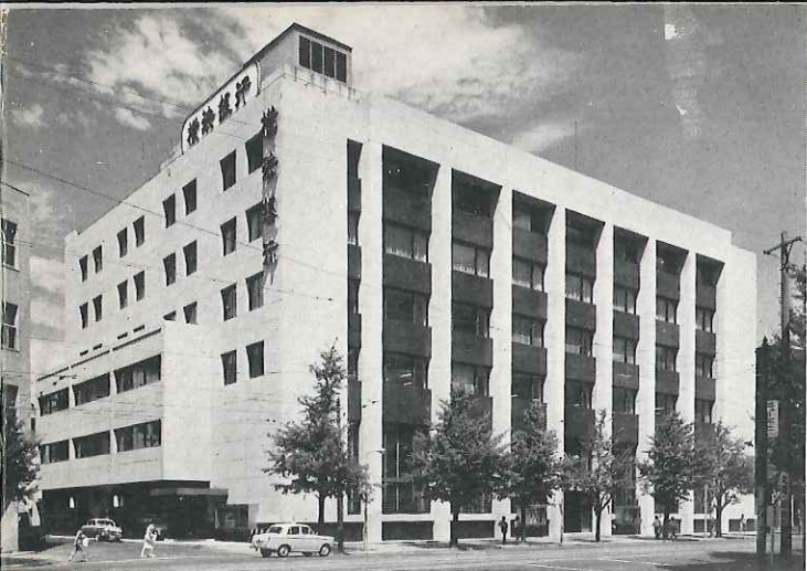
▲ 横浜銀行本店 (横浜市中区本町) 設計 山下寿郎設計事務所殿 施工 大成建設殿 工期 昭35.4~昭35.9
