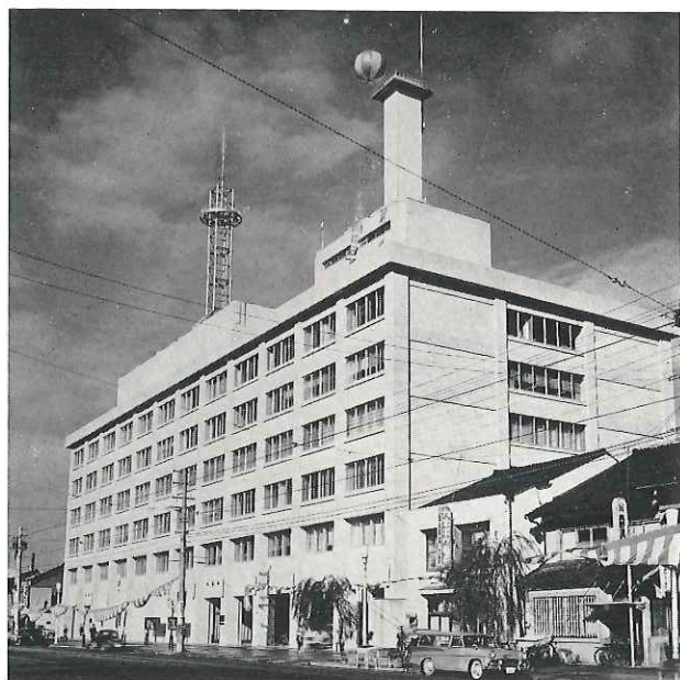
▼ 北陸銀行本店 (富山市西堤町) 設計 日建設計工務殿 施工 大林組殿 工期 昭36.5~昭36.10
