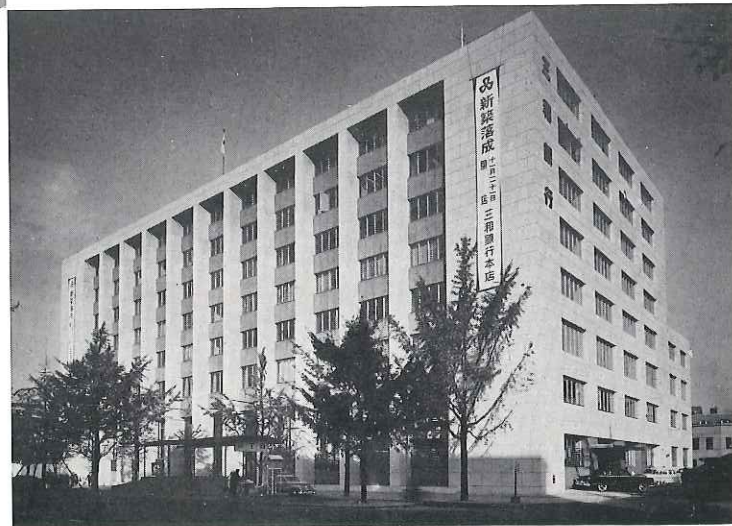
▶ 三和銀行本店 (大阪市東区伏見町) 設計 山下寿郎設計事務所殿 施工 大林組殿 工期 昭30.5~昭30.11
