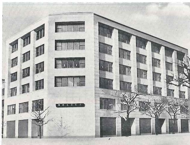
◀ 東邦生命ビル (札幌市北一条) 設計 久米建築事務所殿 施工 鹿島建設殿 工期 昭28.5~昭28.10
