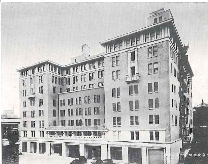
▶ 朝鮮ビル (朝鮮・京城) 設計 高橋建築事務所殿 施工 間組殿 工期 昭10.5~昭10.10
