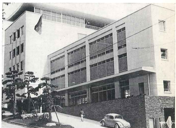
▼ ドイツ大使館 (東京都港区麻布) 設計 松田平田設計事務所殿 施工 竹中工務店殿 工期 昭34.12~昭35.3
