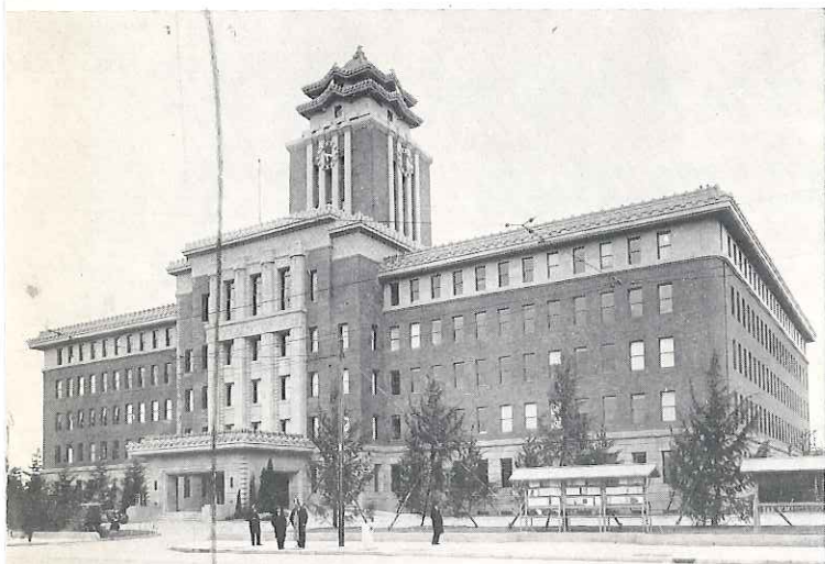
◀ 名古屋市庁舎 (名古屋市) 設計 名古屋市管繕課殿 施工 大成建設殿 工期 昭6.11~昭8.10
