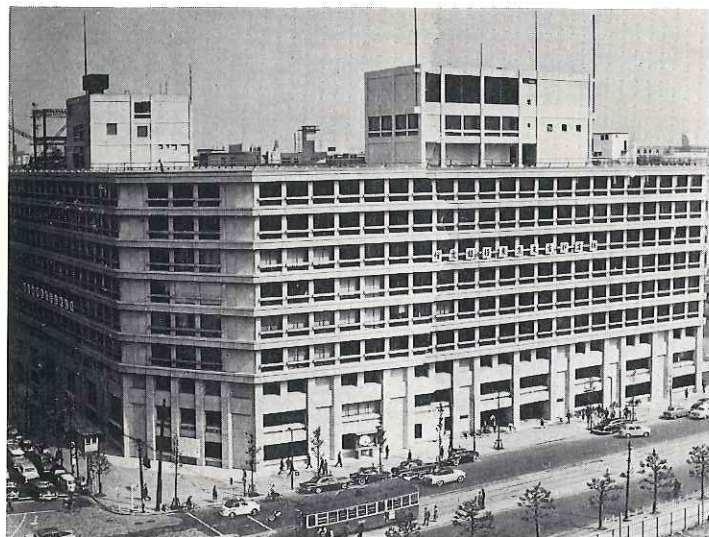
▲ 新住友ビル (東京都千代田区丸の内) 設計 日建設計工務殿 施工 清水建設殿 工期 昭33.8~昭34.3
