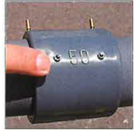
⑧融着完了 → インジケータ隆起確認
